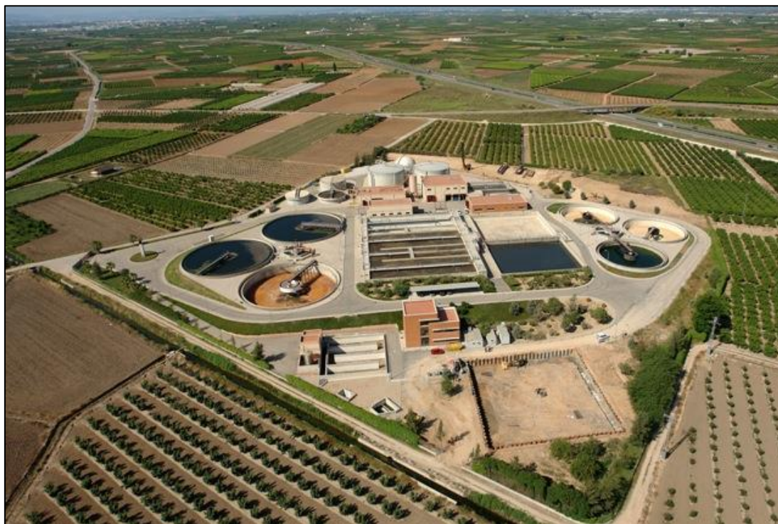
Figura 8. Estación Depuradora Albufera Sur
