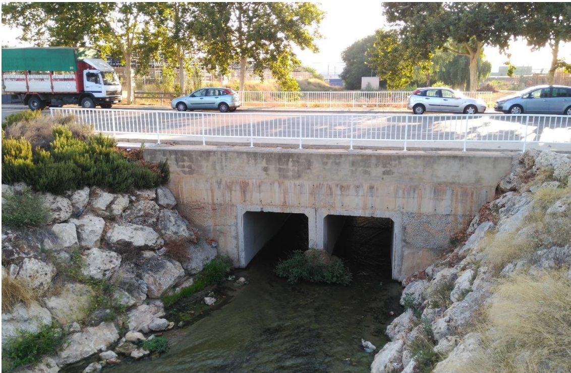
Ilustración 11. Acequia de la Foia. Marcos de 2x2m bajo la Avda. de la Foia (lado oeste).
