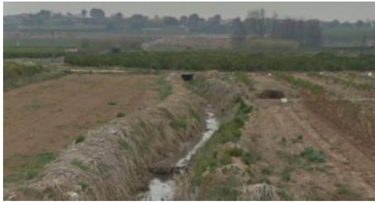
Ilustración 4. Acequia de la Foia aguas arriba de la autovía A-7.
