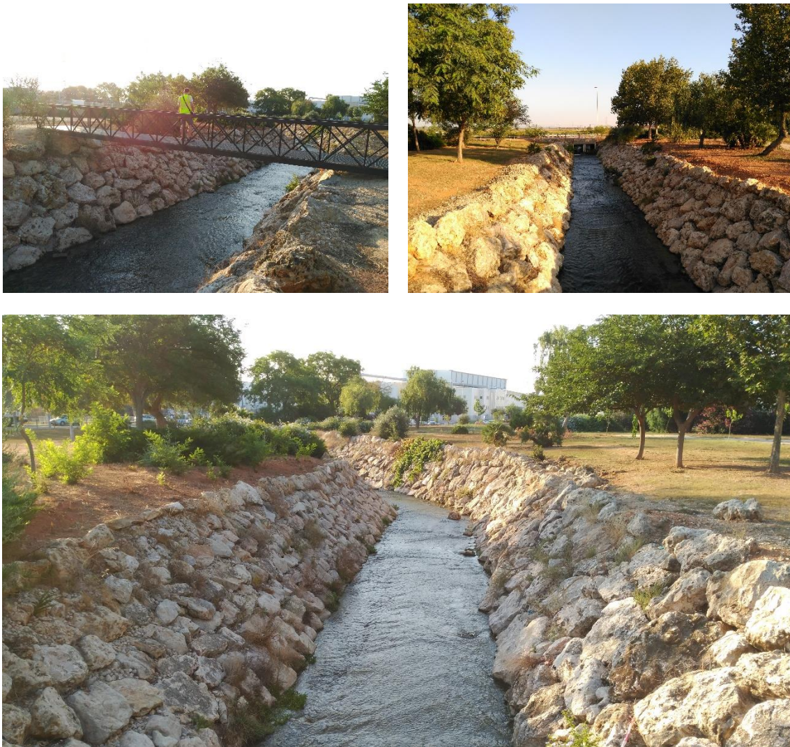
Ilustración 10. Acequia de la Foia. Canal a cielo abierto al este de la Avda. Henry Ford.
