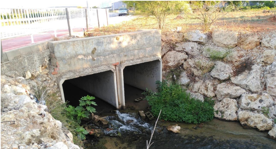
Ilustración 9. Acequia de la Foia. Marcos de 2x2m bajo la Avda. Henry Ford (lado este).
