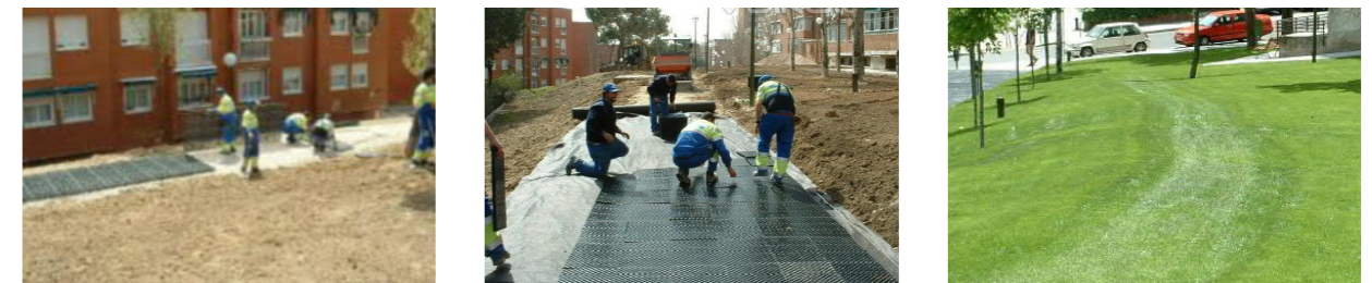
Figura 41. Instalación de celdas de drenaje bajo pavimento. Zona de captación deprimida.
