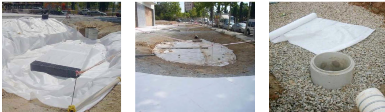
Figura 56. Construcción de zonas de detención e infiltración con sub-bases de gran capacidad de acumulación de agua.
