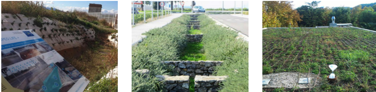
Figura 66. Cuneta vegetada en Ciudad del Deporte. Cuneta vegetada en Ronda Norte. Cubierta vegetada en colegio.
