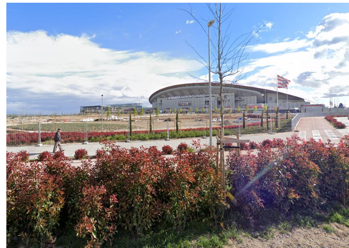
Después de la construcción.
