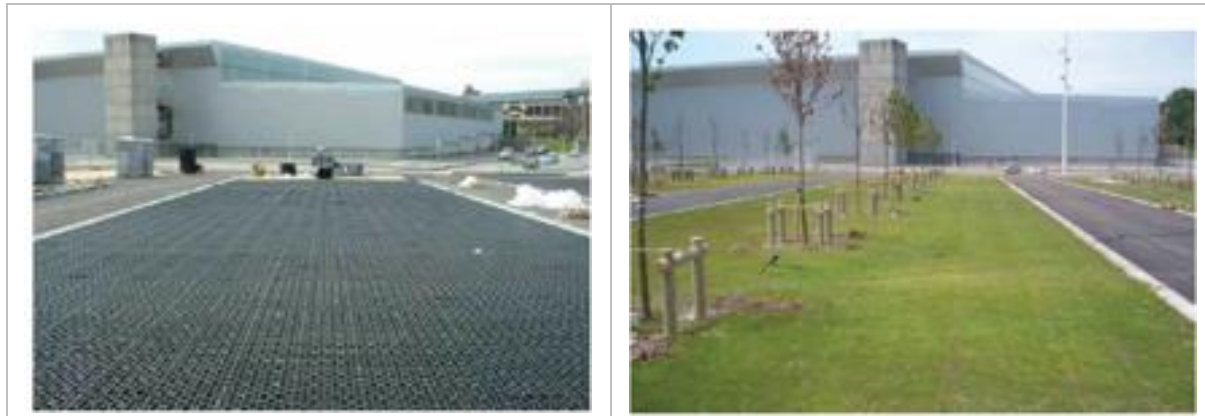
Pavimento permeable con pequeño aljibe. Fuente: Guías de adaptación al riesgo de inundación: SUDS. MITECO. Octubre 2019
