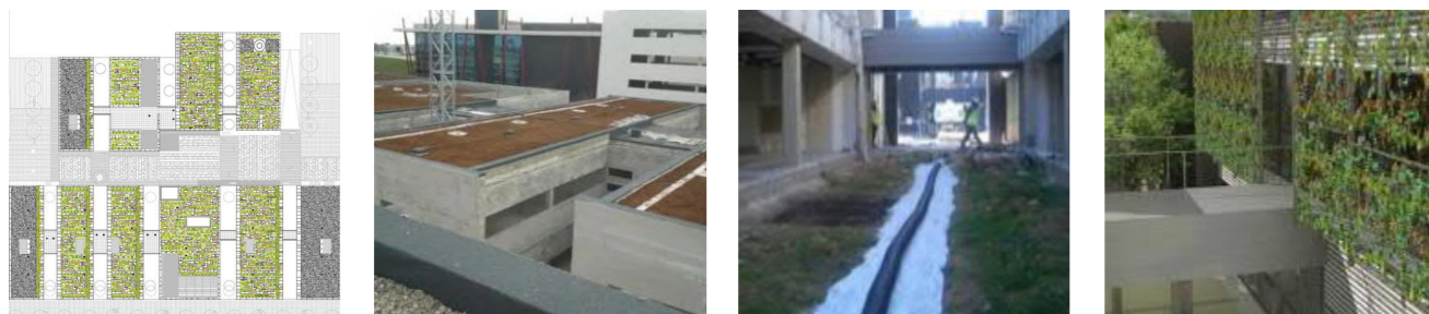
Figura 44. Complejo balear de investigación, Parc Bit. Cubiertas vegetales, zanja drenante en patio y fachada vegetada.
