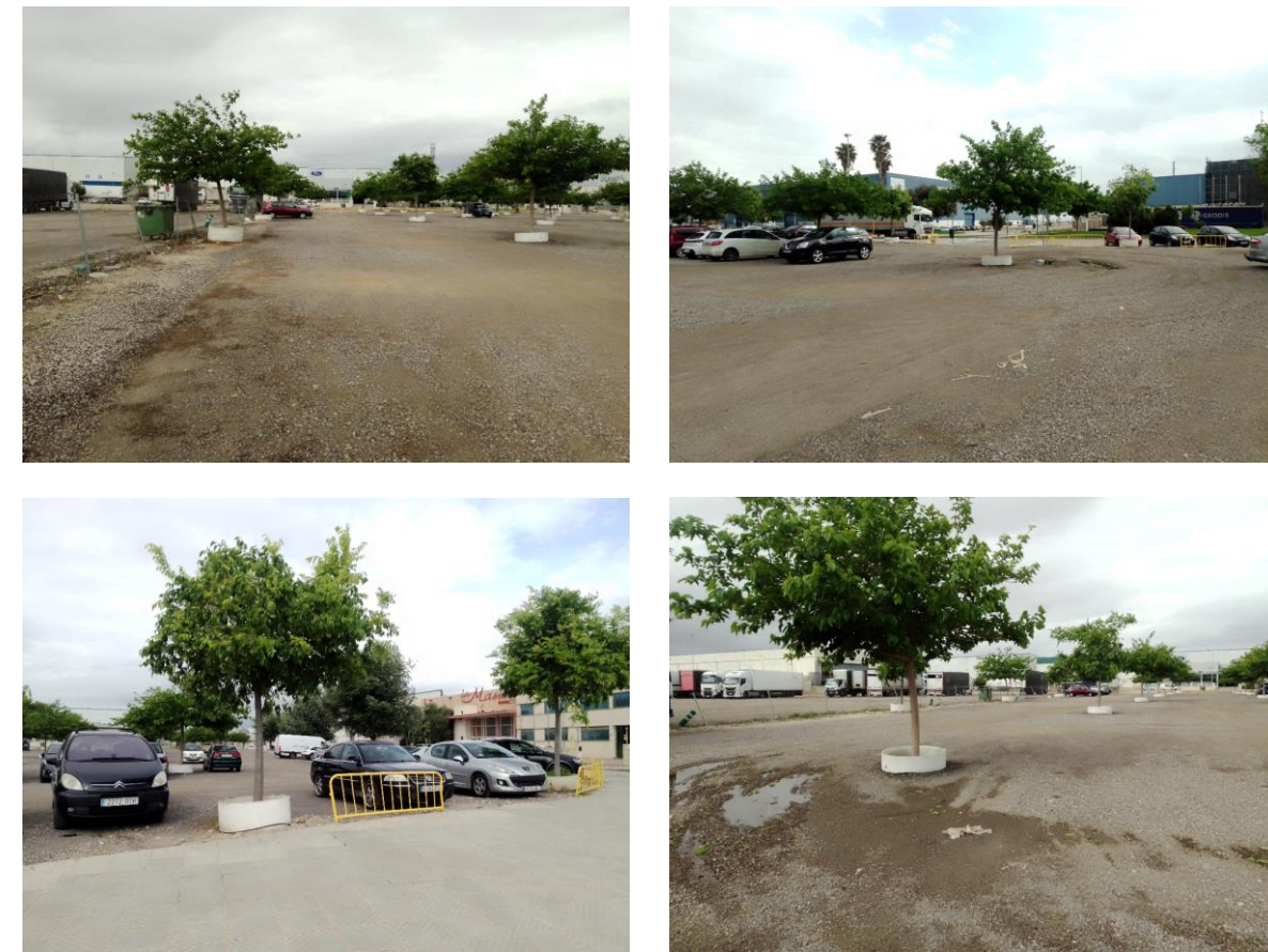
Imagen 10. Estado actual del aparcamiento y su remate con el vial actual. Elaboración propia
