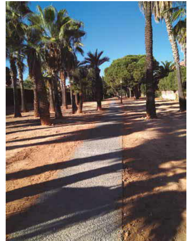
Zanja drenante Mas Camarena
