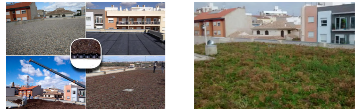
Figura 64. Construcción de la cubierta y resultado final de la cubierta vegetada.
