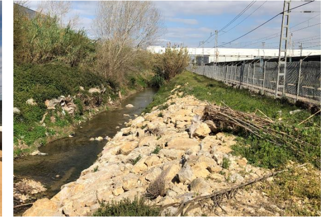
Imagen 7. Acumulación de cañas junto al muro medianero en la misma zona después de un episodio de lluvias torrencial. Elaboración propia
